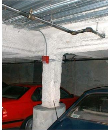
รูปที่ 3 - 17 ตัวอย่างเสาและคานเหล็กทนไฟ
