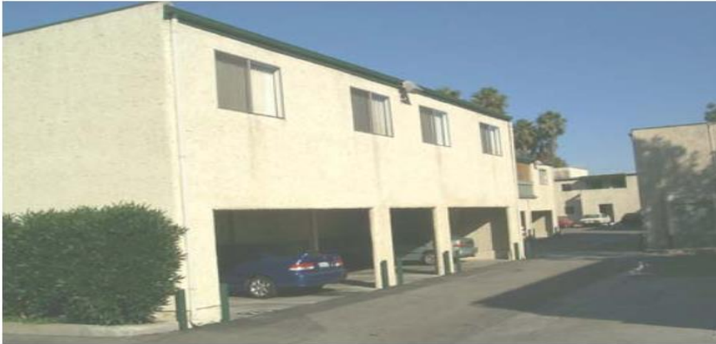
รูปที่ 3 - 10 อาคารที่มีชั้นล่างสุดเป็นที่จอดรถ (tuck under)
