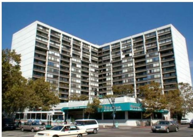
รูปที่ 3 - 12 ตัวอย่างอาคารที่มีความไม่สม่ำเสมอในแนวระนาบแบบมีมุมหักเข้าข้างใน
