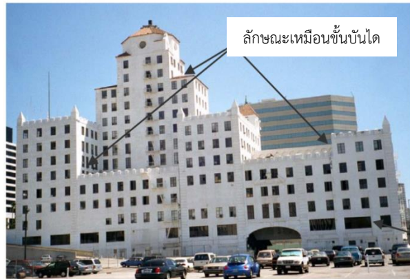
ก. ตัวอย่างอาคารที่มีความไม่สม่ำเสมอในแนวตั้ง
